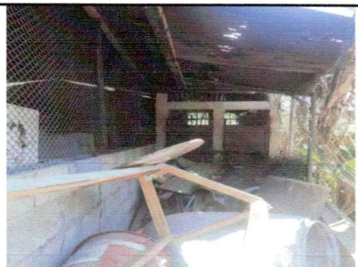
Foto 4: Sustitución de lámina, por lámina troquelada aluzinc calibre 26 y estructura portante, y muro perimetral
