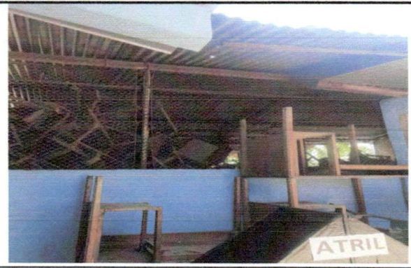
Foto 2: Sustitución de lámina, por lámina troquelada aluzinc calibre 26 y estructura portante
